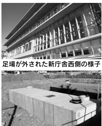
外構工事(防火水槽設置)の様子
